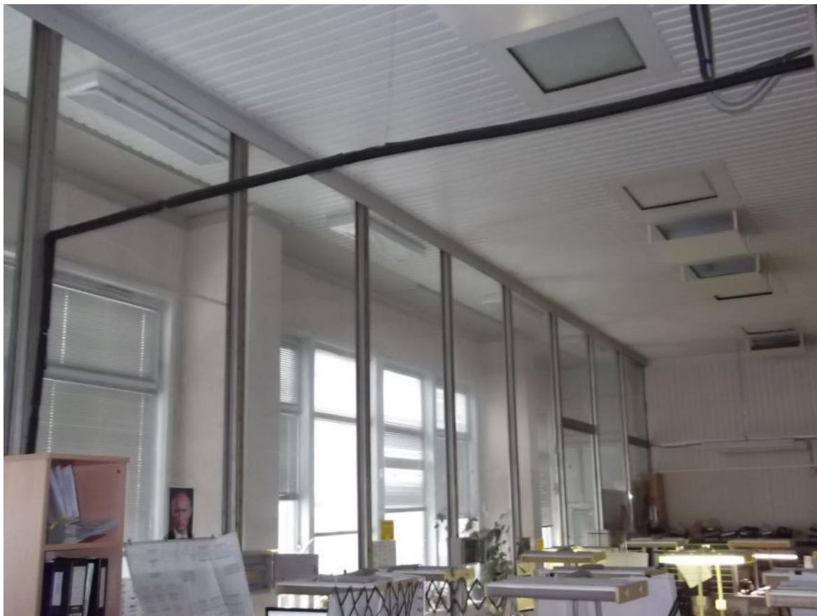
Фото А.3 – Общий вид пом.310, 3-й этаж, корпуса №30 в осях «В-Г/6-11». Внутренняя перегородка помещения №310 выполненная из стеклянных блоков
